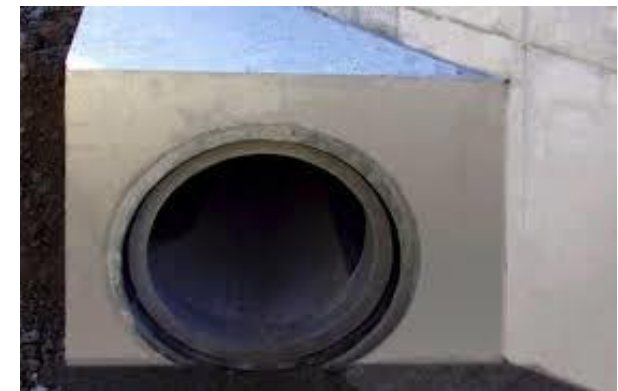
Слика 11 влез на атмосферската канализација во ретенционниот базен
